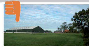
Grote schuur niet in verhouding tot de andere bebouwing. Daarnaast zijn er doorzichten naar het achterliggende gebied.
