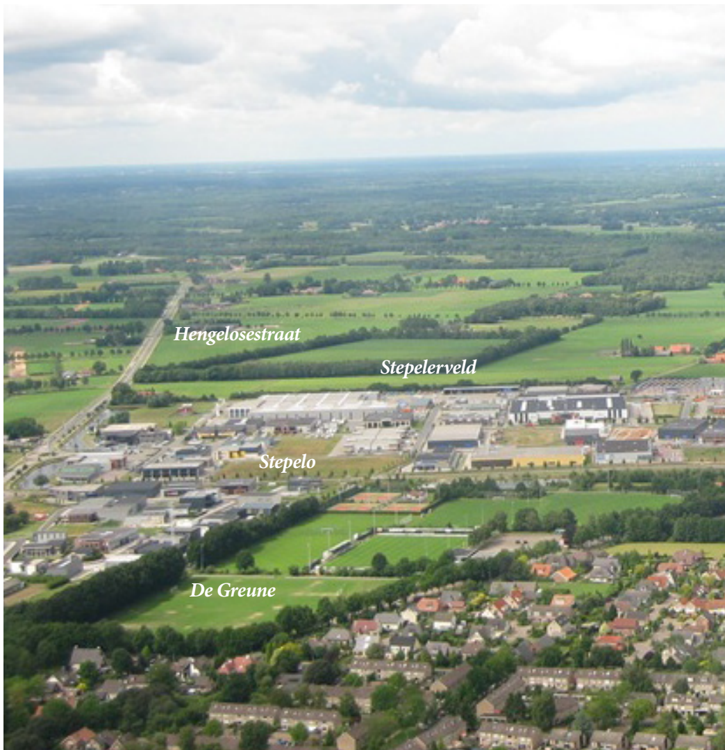
Kolenbranderweg wordt de entree vanaf de N18 en krijgt de allure van eenallee Stepelerveld wordt een bedrijventerrein in een groene setting
