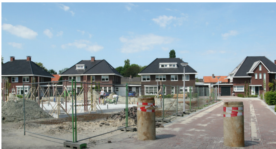
Nieuwbouw nabij Veldkampstraat
