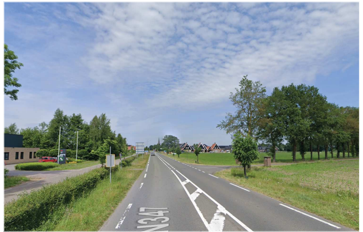
Zuidzijde St. Isidorushoeve
