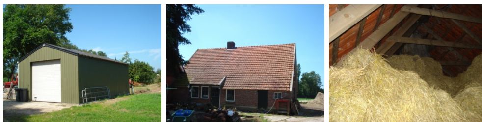
Foto's: Indrukken te slopen opstallen.
