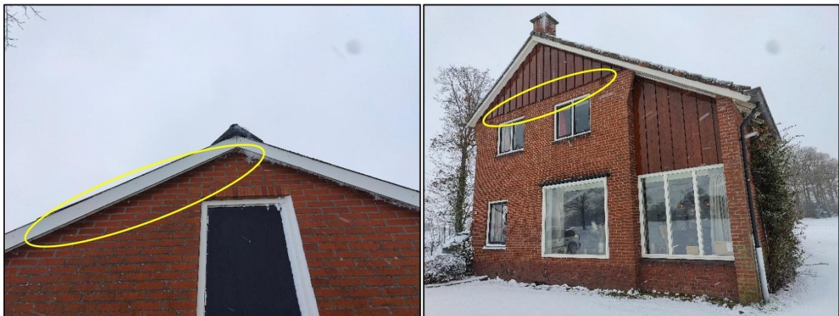
Foto 1 en 2: De schuur en de woning beschikken over een spouwmuur waarin vleermuizen een verblijfplaats kunnen hebben. Daarnaast heeft de woning gevelbetimmering waarachter vleermuizen eveneens een verblijfplaats kunnen bezetten.
