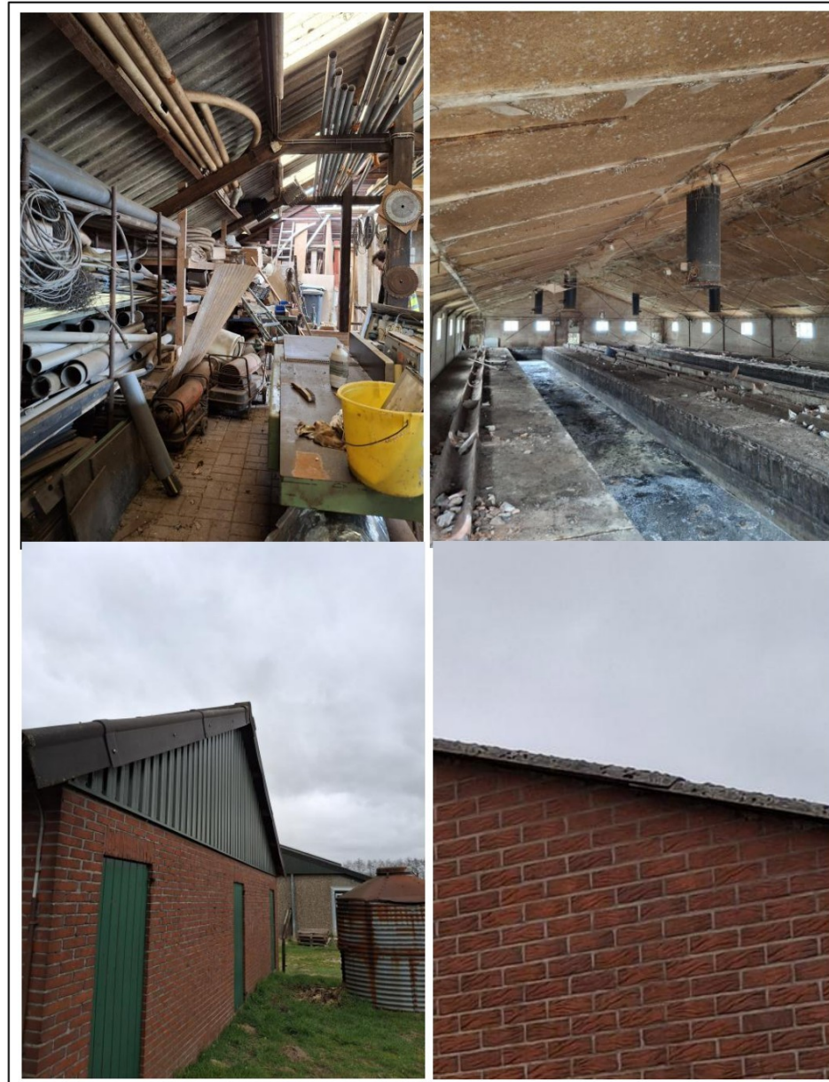
Figuur 4. De loods op het terrein (linksboven) is in figuur 3 aangegeven met de letter A en er is veel lichtinval. Stallen C en D hebben veel ramen met veel lichtinval (rechtsboven). Stal C heeft de golfplaten direct op het dak liggen (rechtsonder), stal D heeft golfplaten aan de zijkant van de muur zitten die erg glad zijn voor vleermuizen (linksonder).
