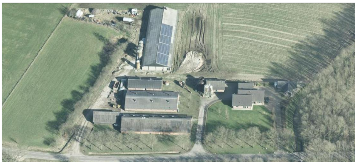
Afbeelding 3 – Bebouwing bestaande situatie
