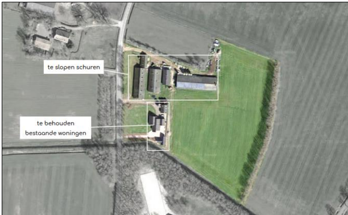
Afbeelding 4 – Te slopen bebouwing
