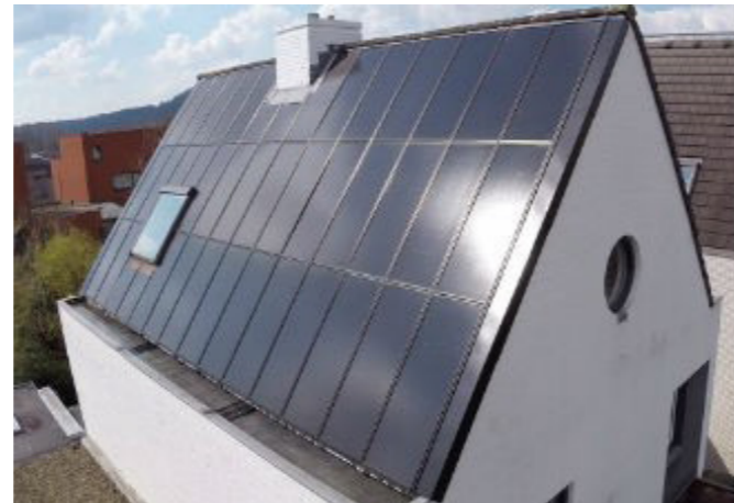
Het hele dakvlak bedekt met zonnepanelen
