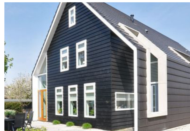
Kozijnen en daklijsten wit
