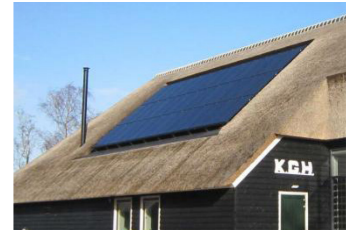
Zonnepanelen verzinkt in het rieten dak
