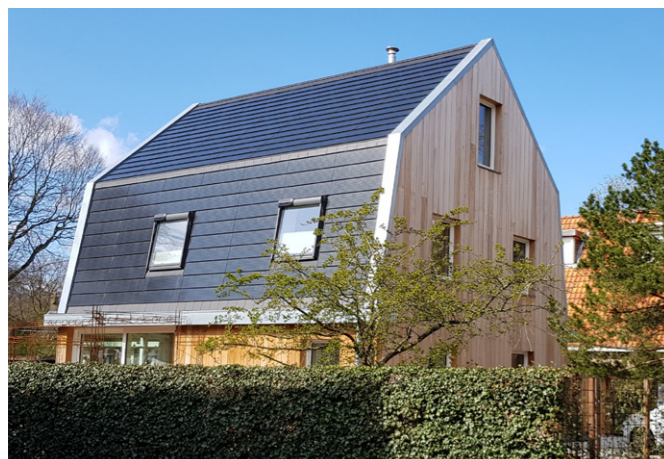
Mansardedak met zonnepanelen
