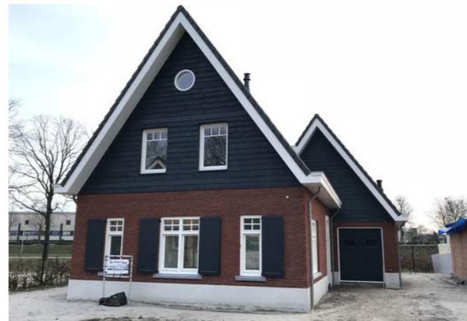
Bakstenen gecombineerd met hout
