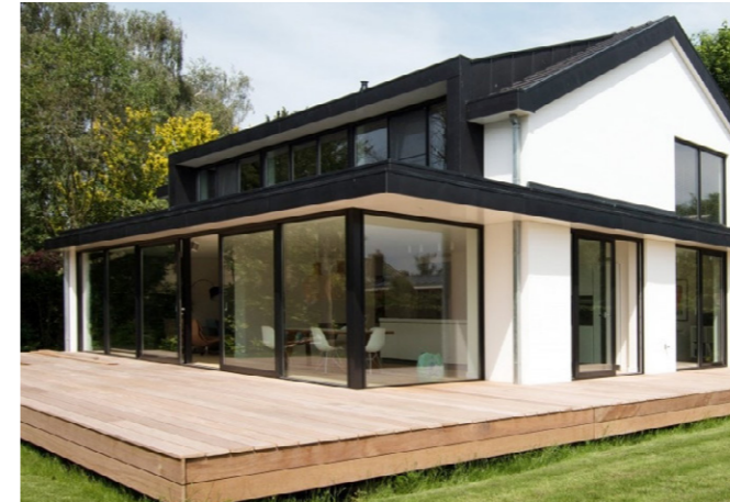
Uitbouw met platdak aan achterzijde
