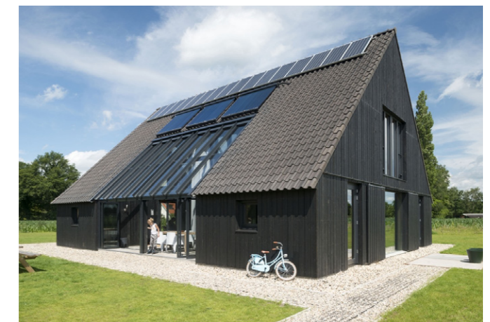
Dakvlak van glas
