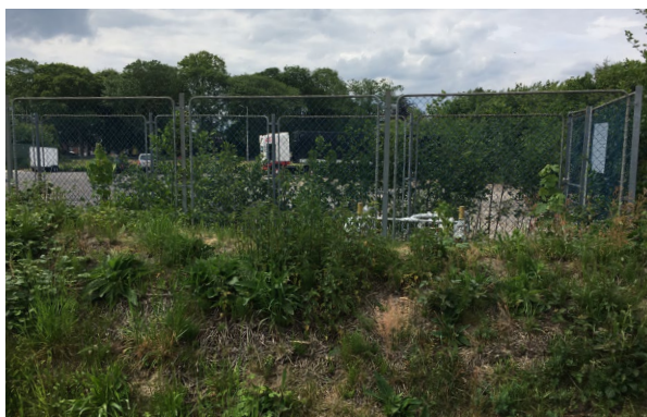
Afbeelding 11. Gastank met grondwal op terrein.
