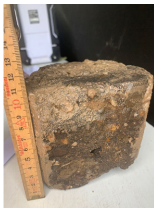
Afbeelding 6. Boring B02, laag 0,07-0,18 m
