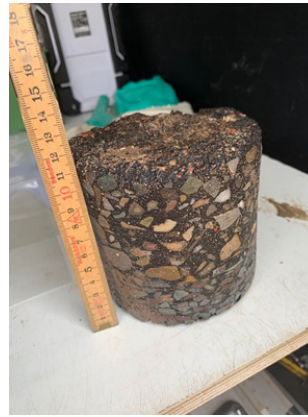
Afbeelding 14. Boring B14, laag 0-0,12 m
