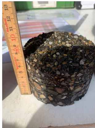
Afbeelding 22. Boring B24, laag 0-0,07 m
