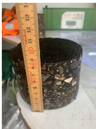
Afbeelding 3. Boring B01, laag 0-0,8 m
