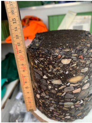
Afbeelding 19. Boring B19, laag 0-0,13 m
