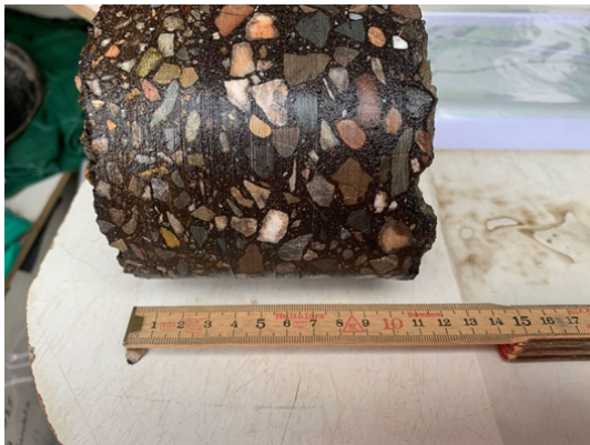
Afbeelding 9. Boring B07, laag 0-0,11 m
