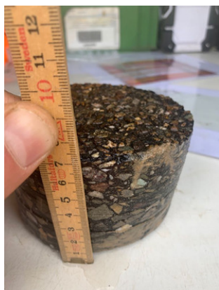
Afbeelding 5. Boring B02, laag 0-0,07 m
