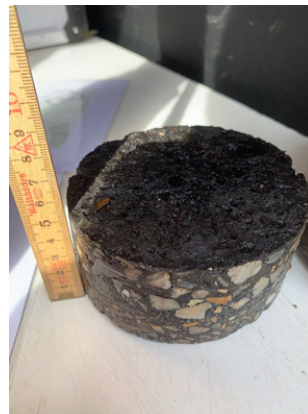
Afbeelding 18. Boring B17, laag 0-0,05 m
