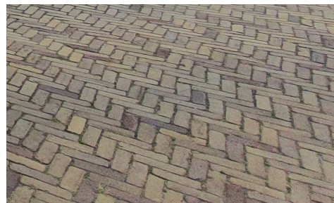
Bestaande (historische) gebakken straatklinkers handhaven / hergebruiken
