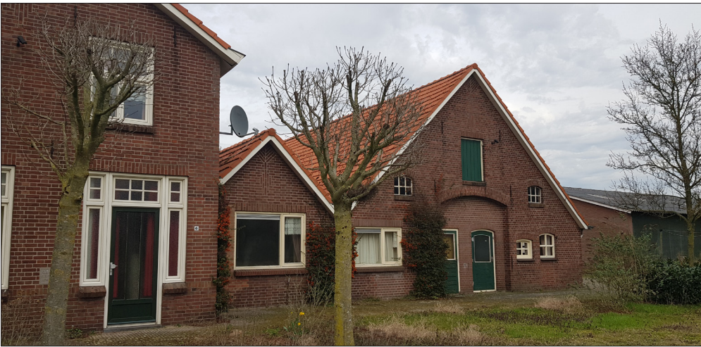
foto 2: Voorgevel woonhuis met aangebouwde bedrijfsgebouwen
