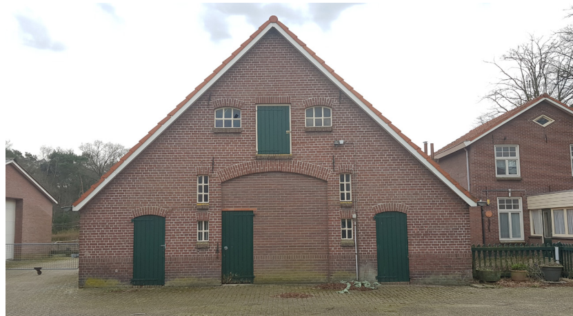
foto 6 : Achtergevel voormalig bedrijfsgebouw. In de achtergevel zijn de contouren van de oude deel / endeur nog zichtbaar, waarin een terugliggende muur is gemetseld. De originele positionering van de gevelopeningen is nog intact.
