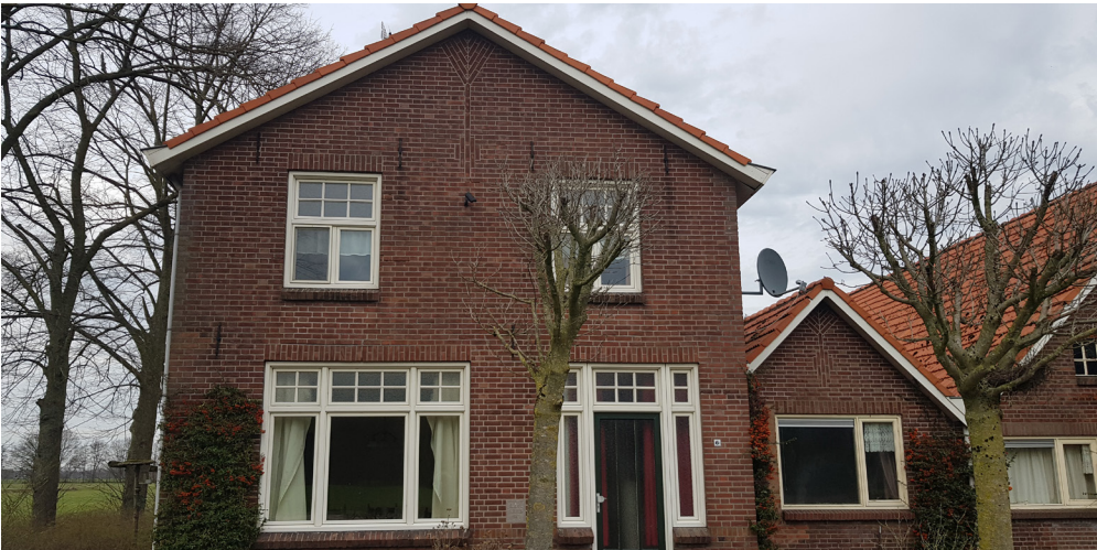
foto 1 : De voorgevel geeft een duidelijk beeld van een geschakelde bebouwing. De mansardekap is in de jaren 70 vervangen voor een zadeldak. Hierbij is het metselwerk op de verdieping opgetrokken. De voorgevel van het woonhuis is nog gemetseld in vlaams verband, deze is in de overige gevels niet terug te zien. In de topgevels van de bouwwerken is indentiek siermetselwerk aangebracht. De kozijnen van het woonhuis zijn reeds vervangen voor kunststof kozijnen met passende verdeling en roeden. De muurankers van de balklaag zijn terug te zien in de gevel.
