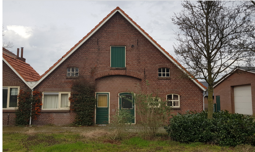
foto 3 : Karakteristieke voorgevel voormalig bedrijfsgebouw / schuur. Het metselwerk in steensverband komt duidelijk naar voren. De voormalige toegdeuren zijn dichtgezet met achterliggend metselwerk. Diverse deur - raamopeningen zijn in het verleden vervangen. In het metselwerk is het trasraam en rollaag nog zichtbaar evenals de togen boven de ramen en (voormalige) deuren. Daarnaast komt het siermetselwerk terug in de topgevel.
