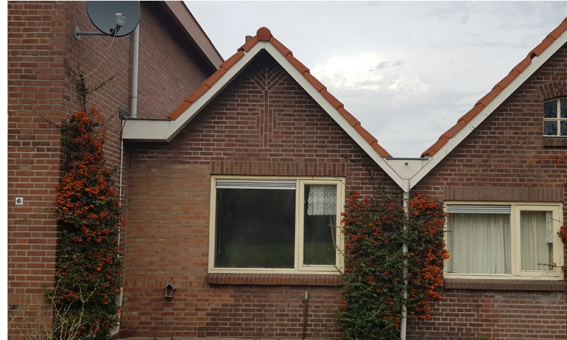
foto 4 : Het tussenlid tussen de bestaande schuur en het woonhuis, voor beoogd en oorspronkelijk gebruik als bijkeuken. In het verleden is een wooneenheid toegevoegd in het tussenlid en is de oorspronkelijke gevel gewijzigd. Hierbij is een groot raamkozijn geplaatst. In de topgevel is nog het oorspronkelijke siermetselwerk te zien. Het overige metselwerk in vlaams verband is nog deels aanwezig. De tussendakse goot tegen de woning is verhoogd ten behoeve van een doorloop tussen de woningen.
