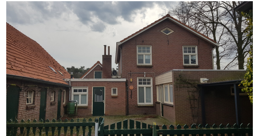
foto 8 : Achtergevel woonhuis en tussenlid met plat dak en achteringang. Het platte dak aan het tussenlid is later aangebouwd evenals de bijkeuken aan de woning. In de achtergevel van de woning is het halfsteensverband duidelijk herkenbaar.
