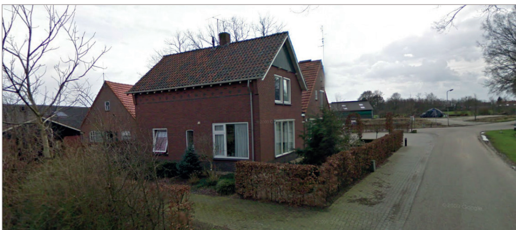
Afbeelding 8. Foto: slooplocatie Mentinksweg 14
