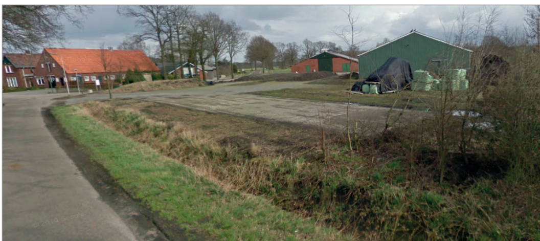
Afbeelding 10. Foto: slooplocatie Mentinksweg 14
