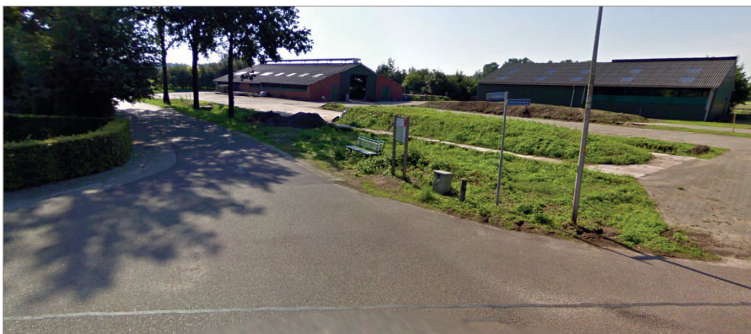
Afbeelding 9. Foto: slooplocatie Mentinksweg 14
