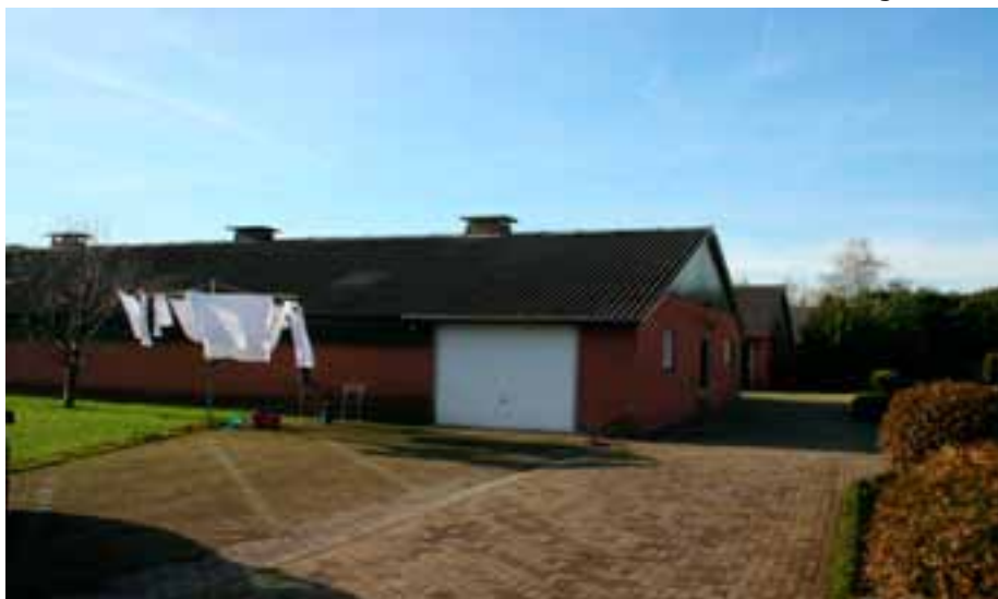
gebouw I, garage
