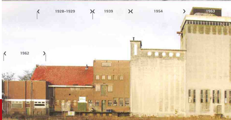
de verschillende bouwfasen van het C.A.V.V. gebouw
