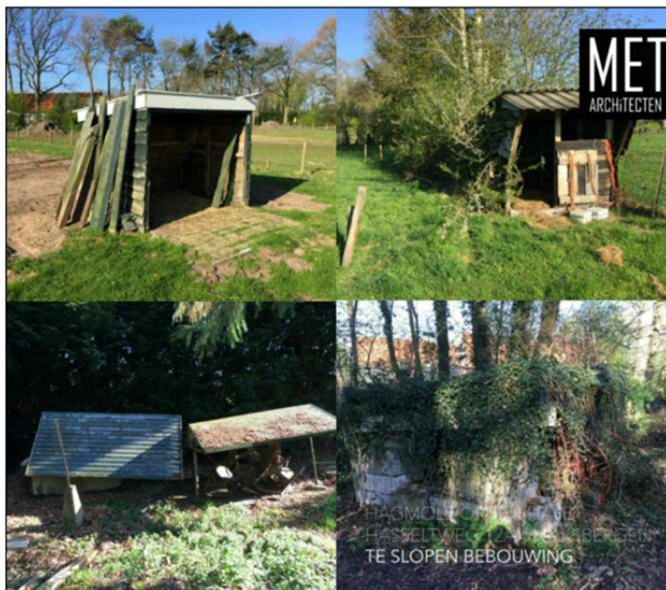
Figuur 3.1 Te slopen opstellen rondom perceel Hasseltweg 12/12a (bron: MET Architecten)
