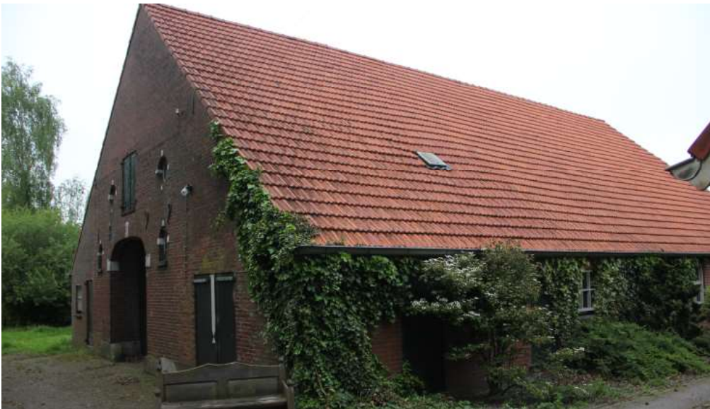
Figuur 20. De te slopen voormalige koestal > 275 m 2
