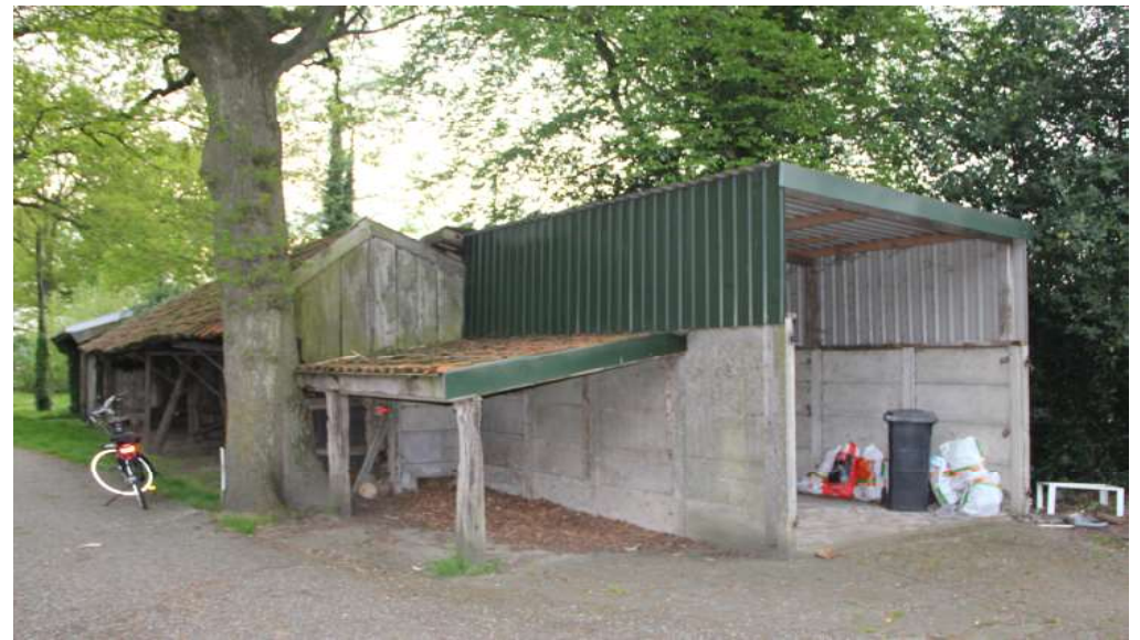
Figuur 22. De te slopen bergingen > 171 m 2
