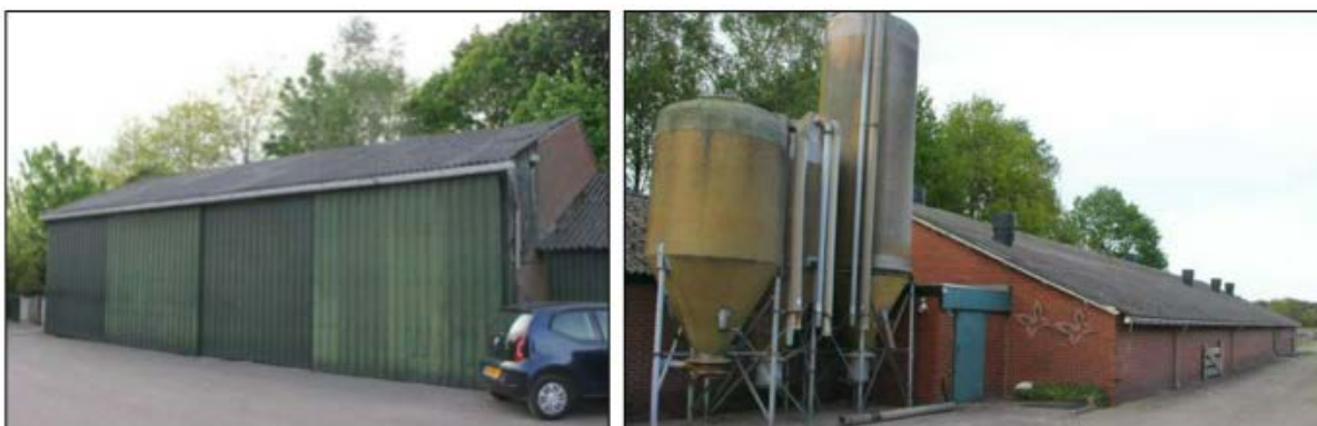
Figuur 2.2 Huidige situatie te slopen bebouwing Eppenzolderveldweg 192-1914 (Bron: Borgerink Groendesign)
