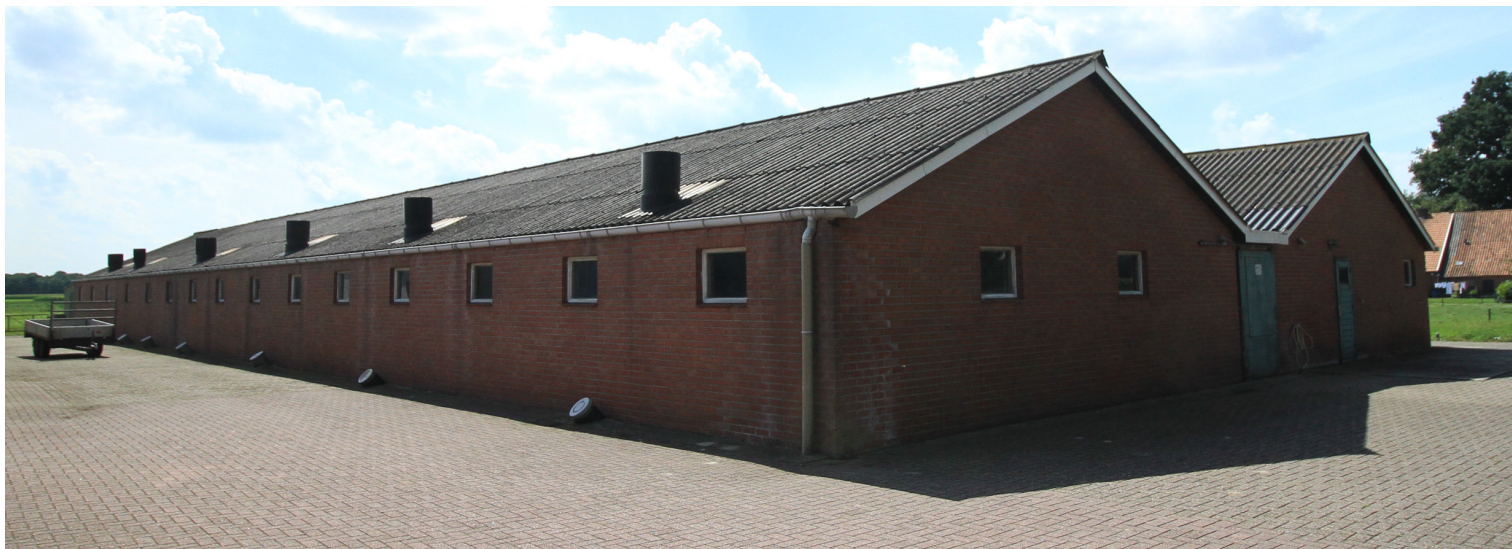
Afbeelding 5. Zicht op bestaande situatie Kinkelerweg 15. De te slopen varkensstallen
