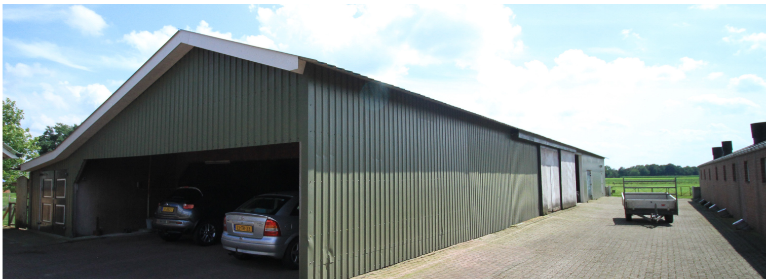
Afbeelding 7. Te behouden kapschuur. (Machineberging en stal) aan de Kinkelerweg 15
