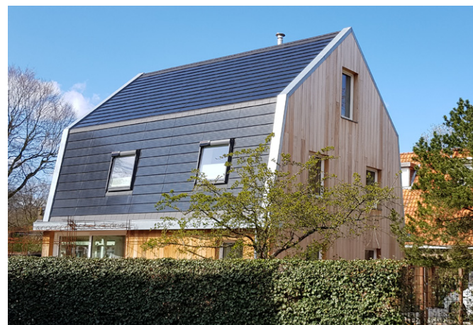
Mansardedak met zonnepanelen
