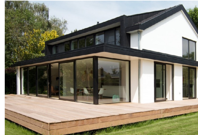
Uitbouw met platdak aan achterzijde
