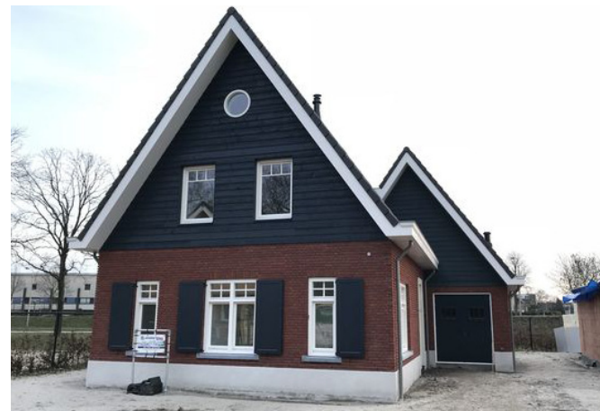
Bakstenen gecombineerd met hout
