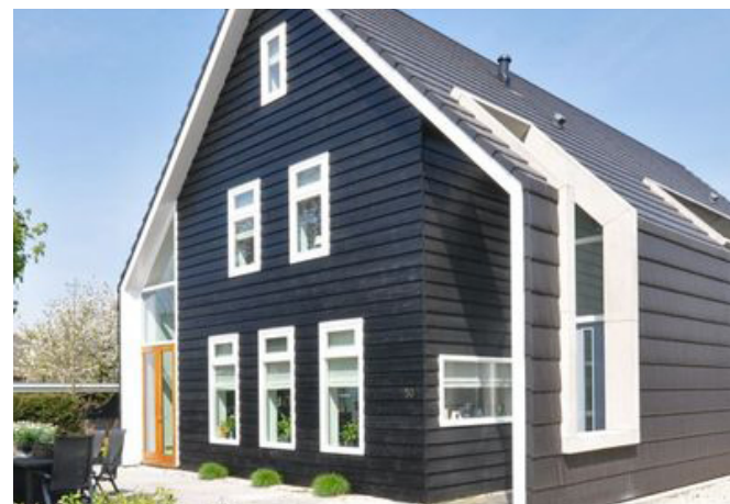
Kozijnen en daklijsten wit
